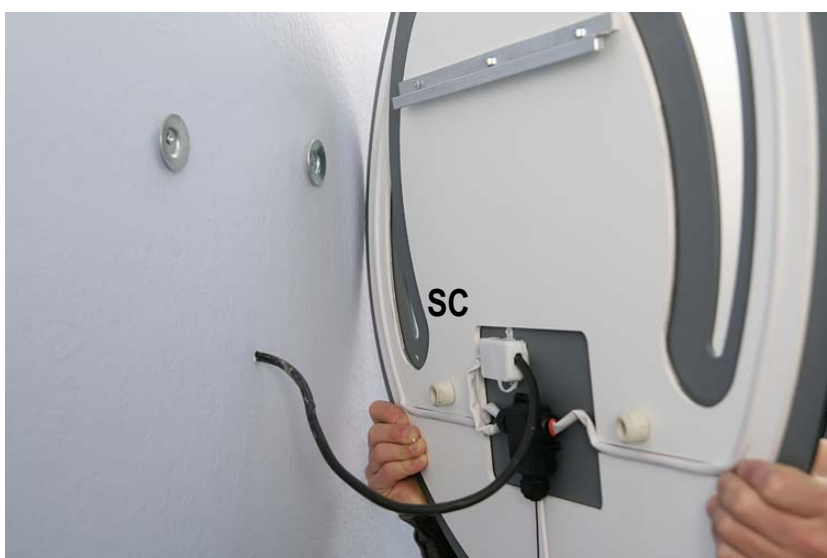
6 allacciamento elettrico /electrical connection
