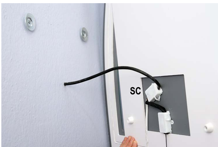
6 allacciamento elettrico /electrical connection
