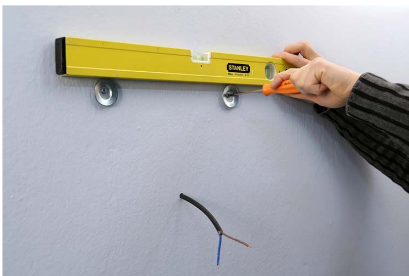
5 regolazione agganci /adjusting the fasteners
