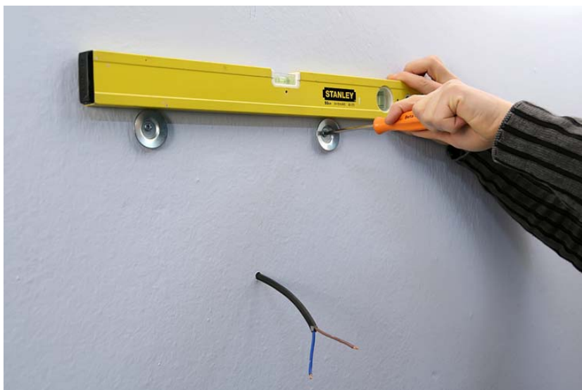
5 regolazione agganci /adjusting the fasteners
